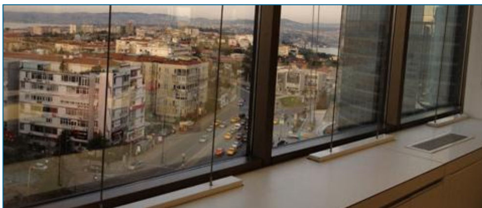
Figuur 3.6.3b: Stalen stangen om de beglazing op te vangen.
