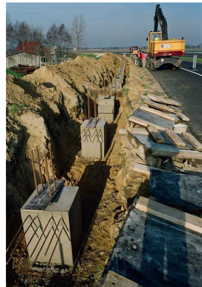
Figuur 17. Fundering voor een geluidsscherm bij Weert Slingertrace Rijksweg A2 (fotograaf: Bart van Eyck, 6-2-1990)
